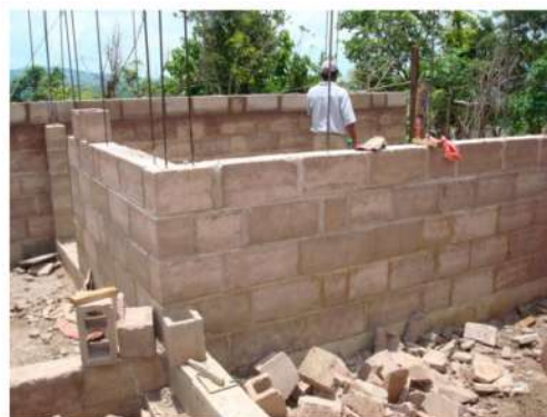
Figura 8. Construcción de los muros reforzados
