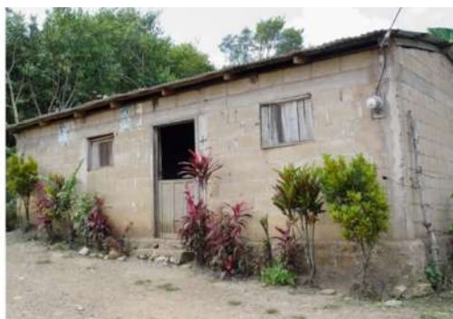
Figura 3. Vivienda típica con muros de bloques huecos
