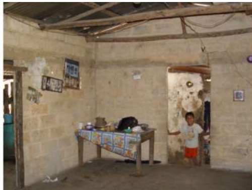
Figura 3. Vivienda típica con muros de bloques huecos
