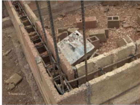
Figura 9. Refuerzo horizontal intermedio
