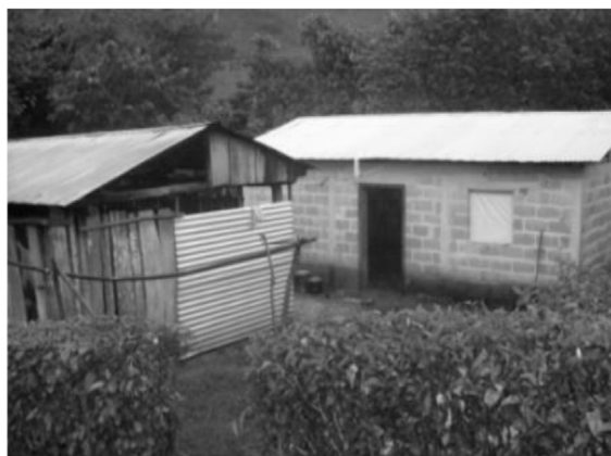
Figura 2. Vivienda rural típica de Yajalón (Chiapas), con paredes de bloque de concreto y techo de lámina.
