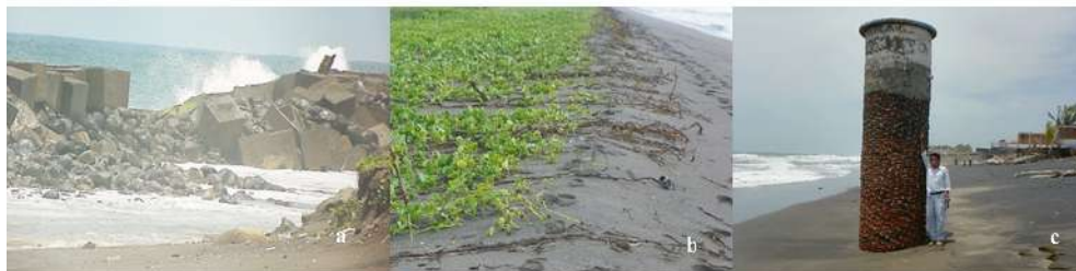
Figura 5. Evidencias de las características de la zona a . Imagen a muestra la barrera de protección artificial de rocas y bloques de concreto; la imagen b muestra vegetación herbácea y la imagen c el nivel de erosión.
