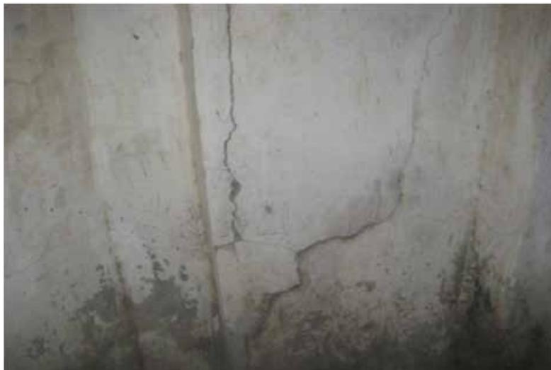
Imagen 6. Fisuras en intersección de muros. Fuente: Elaboración propia
