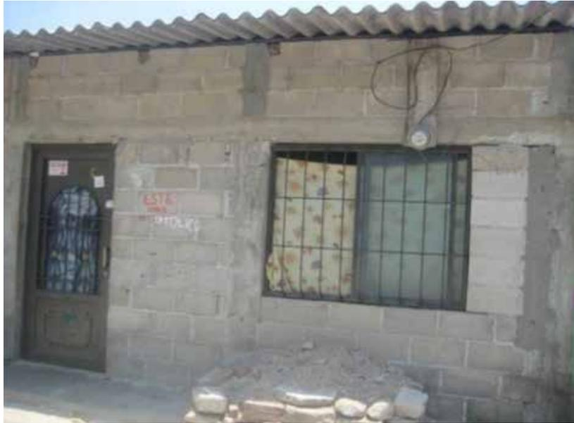
Imagen 7. Ausencia de refuerzo vertical en vanos. Fuente: Elaboración propia
