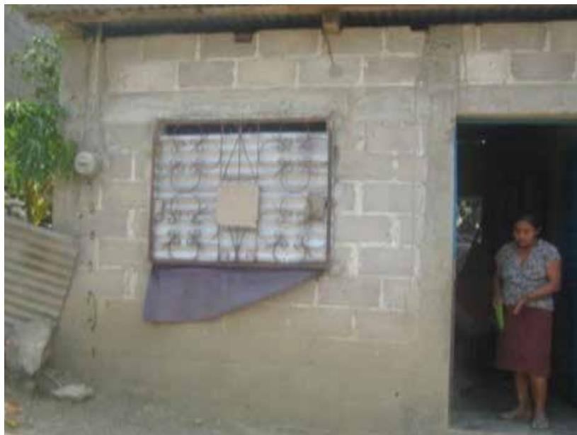
Imagen 8. Ausencia de refuerzo horizontal en ventana. Fuente: Elaboración propia
