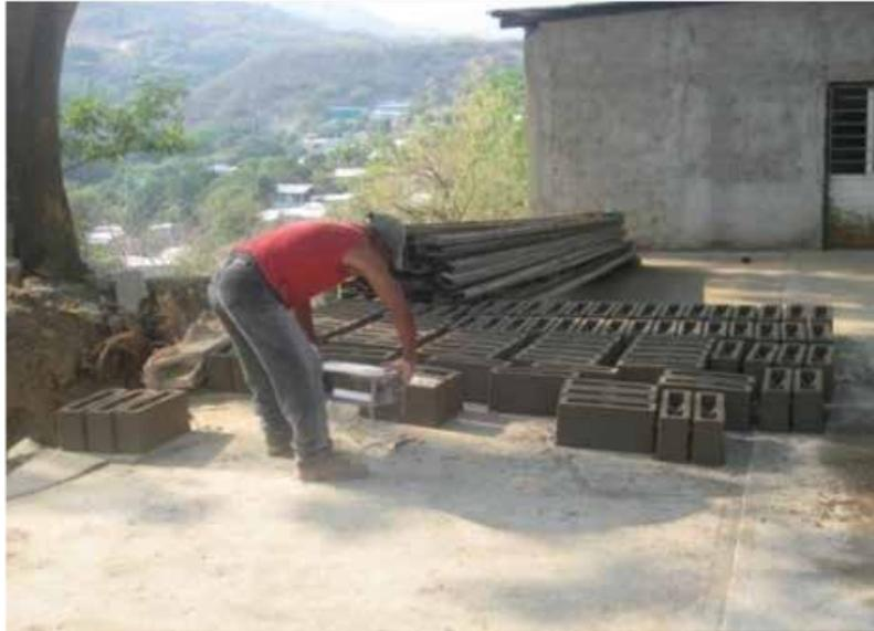
Imagen 12. Almacenamiento y secado. Fuente: Elaboración propia
