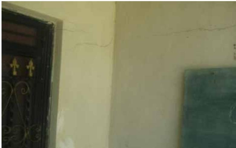
Imagen 5. Fisuras en intersección de muros. Fuente: Elaboración propia
