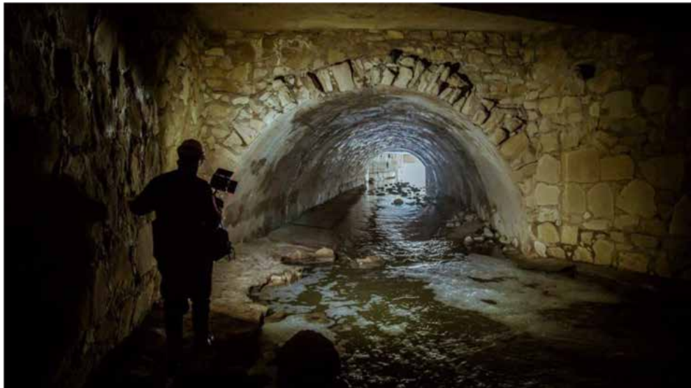
Figura 9. Vista general de un tramo del embovedado de piedra (Tavera, 2018)
