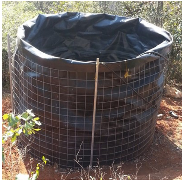
Figura 4. Colector de agua de lluvia domiciliario cimbreado de 1,500 litros
