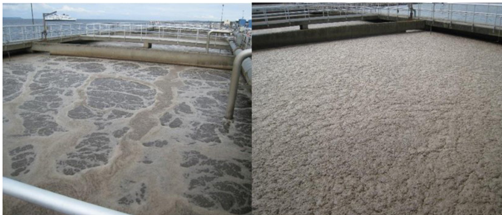
Figura 2. Ejemplo de foaming en un sistema de tratamiento biológico convencional
