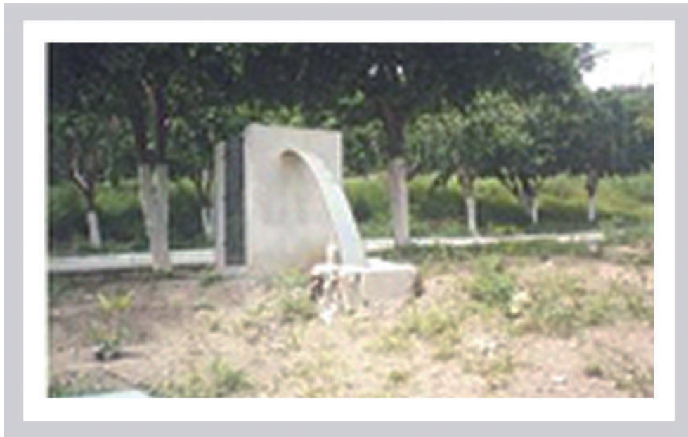
Foto 10. Tanque con sifón laminado
