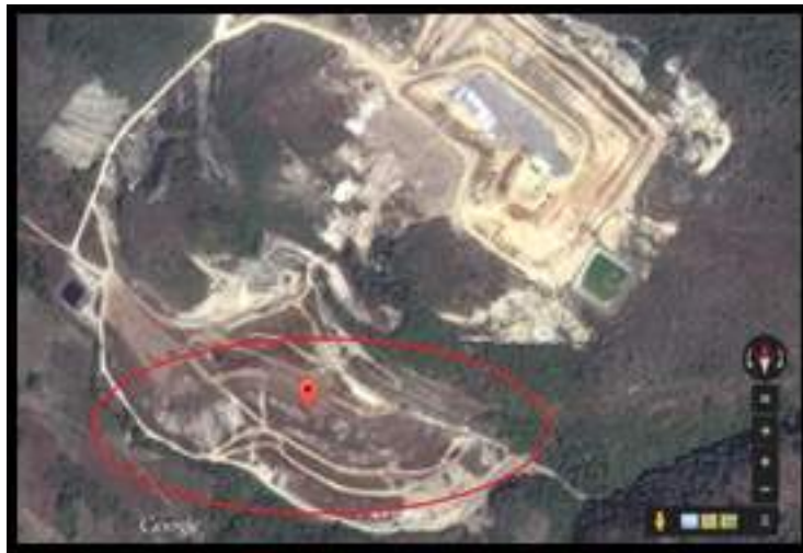
Figura 1. Zona clausurada del relleno sanitario.
