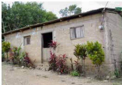
Figura 3. Vivienda típica con muros de bloques huecos
