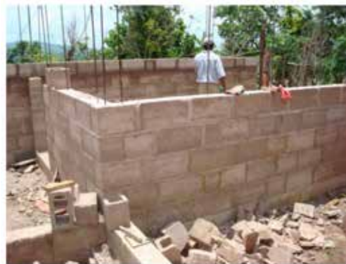
Figura 8. Construcción de los muros reforzados
