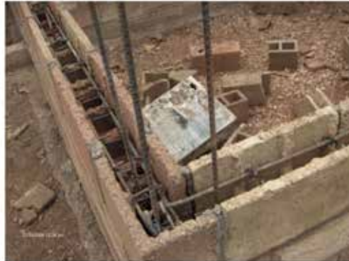
Figura 9. Refuerzo horizontal intermedio
