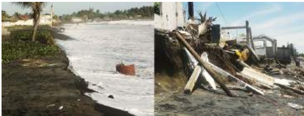
Figura 8. Erosión y daños en la zona a . Se muestra la erosión severa y daños a la infraestructura turística y patrimonio familiar en Puerto Madero, Tapachula, Chiapas. Imágenes de septiembre del 2012.
