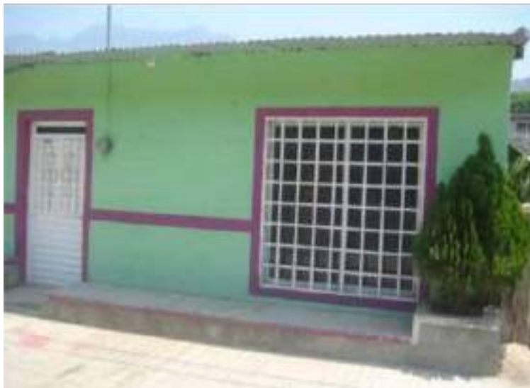
Imagen 9. Fachada de vivienda al pie de calle. Fuente: Elaboración propia
