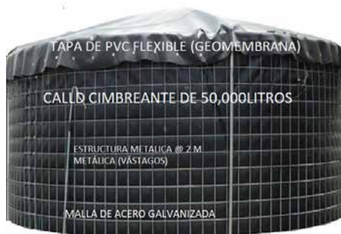
Figura 5. Colector de agua de lluvia domiciliario cimbreante de 50,000 litros
