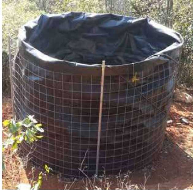
Figura 4. Colector de agua de lluvia domiciliario cimbreante de 1,500 litros
