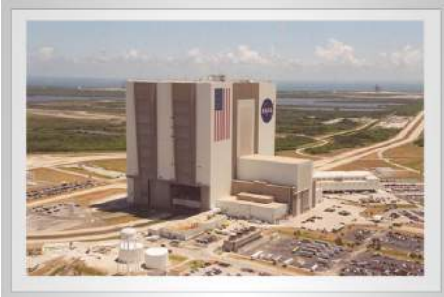
Figura 4. El Edificio de Ensamblaje de Vehículos (VAB) fue construido para el programa Apolo (1964). El VAB fue diseñado para albergar y ensamblar el Cohete Saturno V de 110 metros de altura. Una de las características más notables del VAB son sus puertas de 139 metros de altura (que son las puertas más altas del mundo). El VAB también se utilizó para el montaje del Transbordador Espacial de la NASA. El VAB se utilizará para el montaje/ensamblaje del SLS y el MPCV. Foto cortesía de la NASA.
