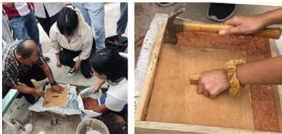
Figura 13. Elaboración del panel de aserrín, producto del aserradero de Monte Sinaí
