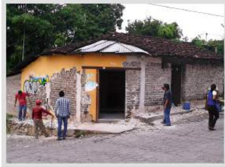
**Figura 4.** Eliminación del mortero existente en la vivienda
