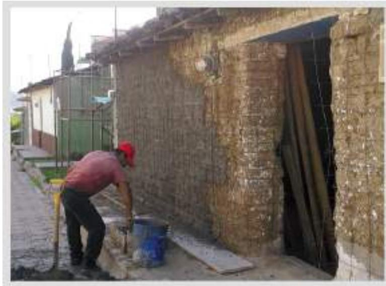
*Figura 12.* Aplicación del mortero cemento-arena
