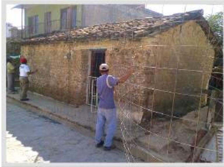
**Figura 10.** Colocación de la malla electrosoldada
