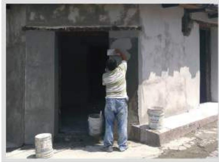
*Figura 7.* Enmasillado con cemento-calhidratada
