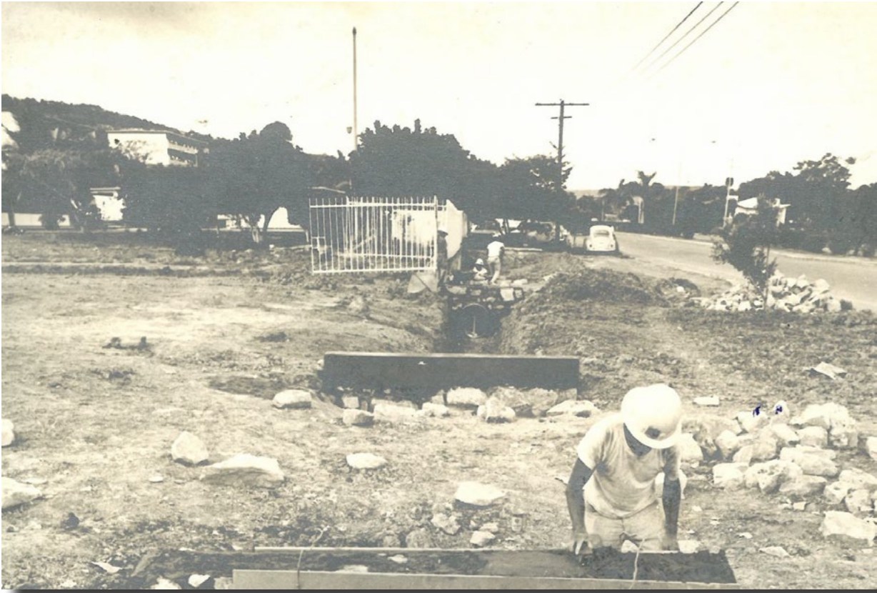
Fotografía 2. Construcción de la Escuela de Ingeniería. Fuente: Serrato (1975).
