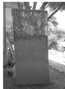
b) Panel de Quincha Prefabricada.
