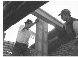
Fotografía 16,17 y 18. Montaje de componentes “prelosa cerámica armada” Fuente: Un techo para vivir.
