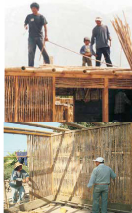
Fig. 9. Imágenes de la construcción de vivienda utilizando quincha mejorada.
