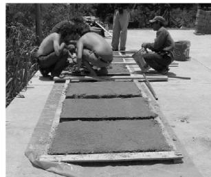
Ilustración 3. Fabricación de muro térmico .
