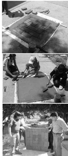
Imagen: 2,3 y 4. Fabricación de una pieza de componente para techo Domotej.
