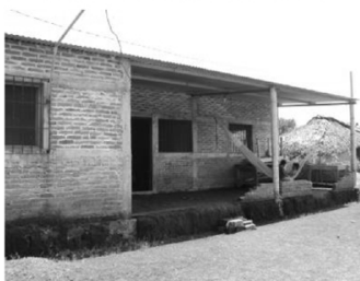
Fotografía 4, 5,6. Vivienda con pórtico con techo de palma, lámina y muros de ladrillo.
