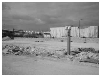
Fig. 6. Predio dispuesto para el emplazamiento del proyecto.
