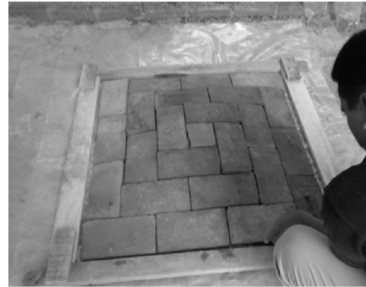
Ilustración 2. Panel de domotej, colocación de los petatillos.
