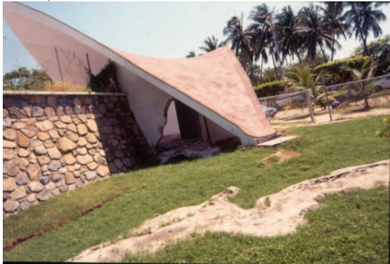
Figura 2. Licuación de arenas en la zona portuaria durante el sismo de Manzanillo (Web Berkeley, 2004)
