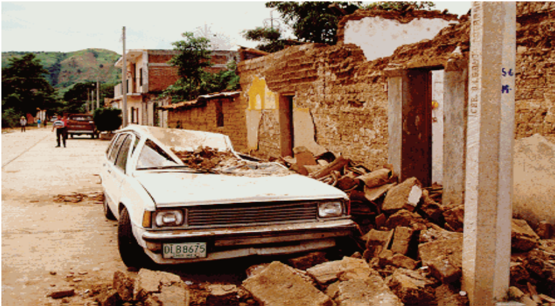
Figura 3. Daños en estructuras de José María Garza, Municipio de Villaflores, fotografía cortesía de Ing. José Alfredo Chan.
