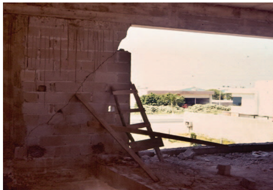
Figura 11. Casas de veraneo cercanas al extinto Hotel Costa Real seriamente dañadas debido a su deficiente o nulo confinamiento.
