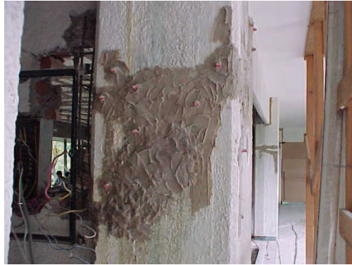
Figura 6 Inyección de grietas
