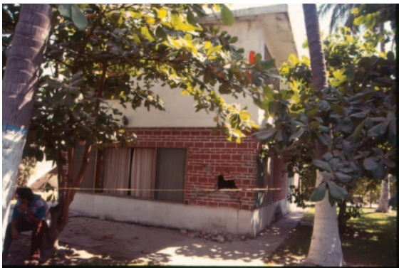
Figura 11. Casas de veraneo cercanas al extinto Hotel Costa Real seriamente dañadas debido a su deficiente o nulo confinamiento.
