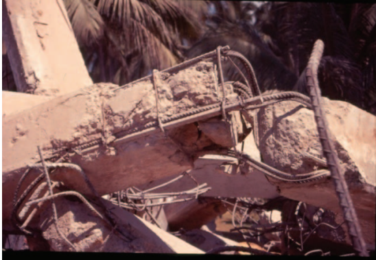
Figura 28. Evidencia del armado original de las columnas del Hotel Costa Real.
