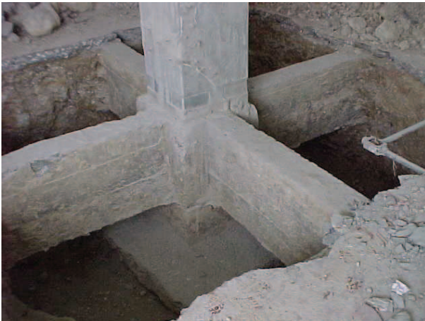
Figura 3 Detalle de cimentación original
