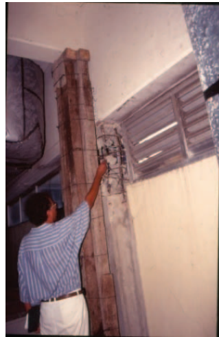
Figura 25. Columnas cortas en el edificio anexo del HGZ-10.
