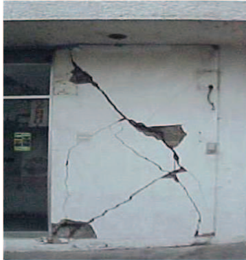
Figura 17. Estructura de mampostería confinada en la ciudad de Tuxtla Gutiérrez (Fotografías cortesía de M.I. Raúl Vera Noguez)
