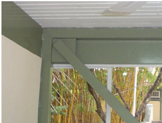
Figura 25. Posterior al sismo la mayoría de las estructuras de escuelas fueron reforzadas con diagonales, al igual que los edificios de la facultad de ingeniería de la UNACH.
