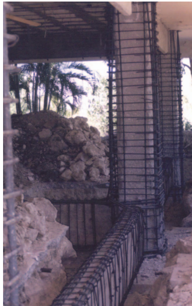
Figura 7 Refuerzo en columnas y contrarribes mediante encamisado
