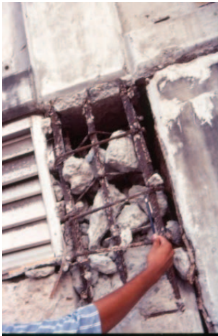
Figura 25. Columnas cortas en el edificio anexo del HGZ-10.
