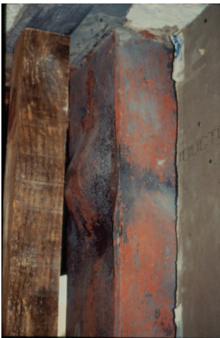
Figura 31. Vistas generales del daño presentado en el Hotel Vidafel por su gran flexibilidad lateral (fotos cortesía de Óscar de la Torre Rangel).
