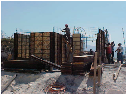
Figura 5 (a y b) Elaboración de viviendas de dos niveles de concreto celular en un fraccionamiento del norte oriente de Tuxtla Gutiérrez
