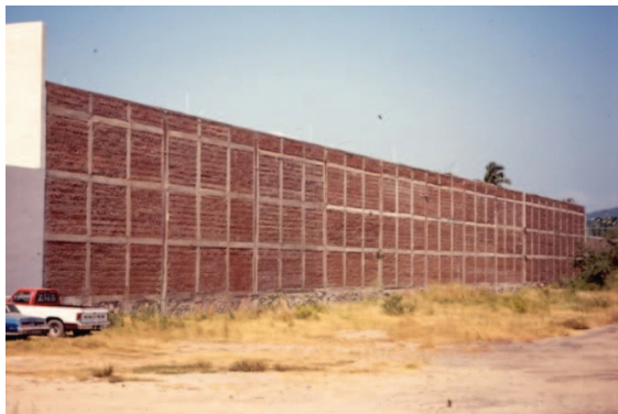
Figura 8. Comportamiento excelente de la bodega de la Cervecería Modelo, estructurada con base en mampostería confinada conforme a las NTCM.
