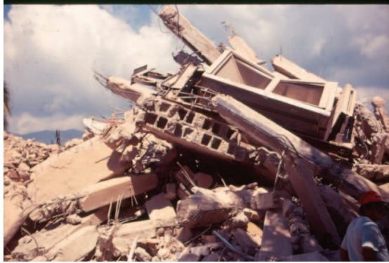
Figura 27. Vistas generales del colapso del Hotel Costa Real días después del sismo.
