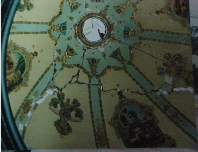
Figura 7. Daños en cúpulas de iglesias elaboradas mediante mampostería sin refuerzo (Fotografía cortesía de Raúl Vera Noguez)
