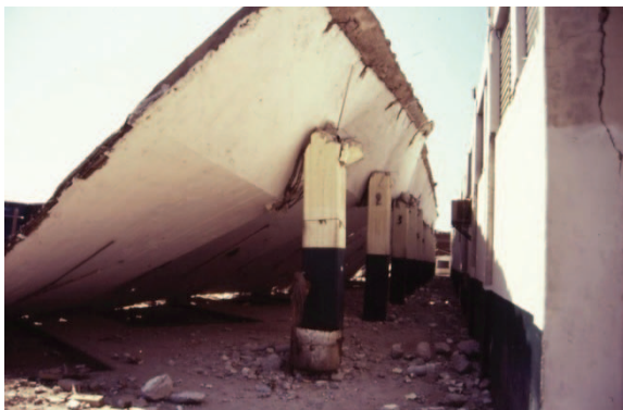
Figura 5. Colapso del paraguas de la Terminal de Autobuses de Manzanillo.
